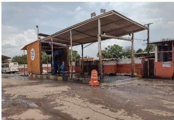
FIGURA 10 - ÁREA DE HIGIENIZAÇÃO EXTERNA
